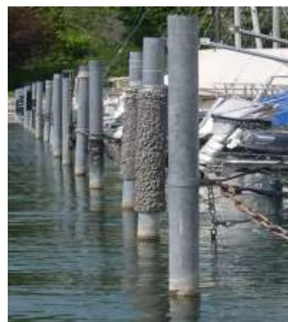
Le système prévu est mobile sur une hauteur de 45 cm évitant ainsi de devoir rapidement couper les amarres en cas de fortes montées des eaux :
