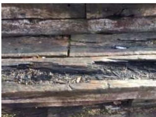
Les gradins ont été construits avec des traverses de chemin de fer et ancrées avec des tiges métalliques. Lors de la réalisation des aménagements extérieurs, consécutivement à la construction du complexe sportif sur ce site, c'est le groupe de l'Entente de Bôle qui a traité les poutres à la lasure afin que ces éléments en bois
