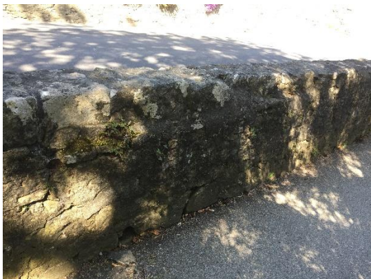
État de dégradation du mur à certains endroits
